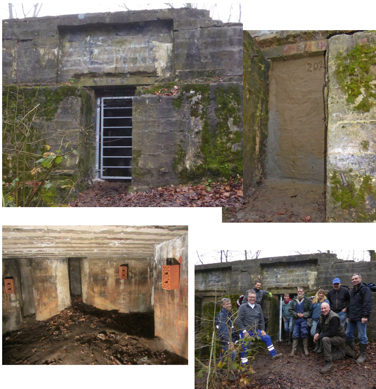
Figuur 75 (a,b,c,d). Inrichting van de bunker in het Steengelaag in Stekene (metalen hekken, dichtmetselen van tweede ingang, plaatsing bouwstenen voor wegkruipmogelijkheden, plaatsing van informatiebord).
