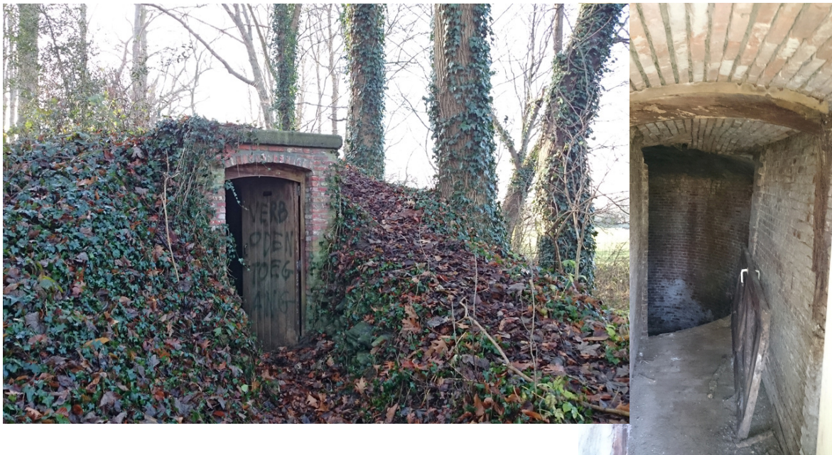
Figuur 77 (a,b). Inrichting van de ijskelder in Sinaai (plaatsing van 2 nieuwe deuren, hier nog niet op de foto).
